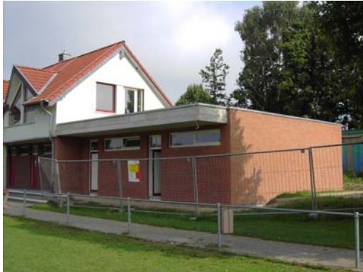
Bei Red.-Schluss noch eine Baustelle: Die Erweiterung der Umkleideräume
